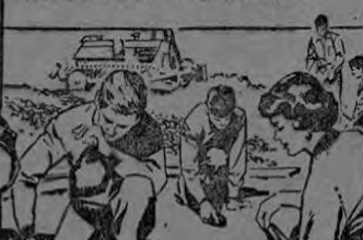
SE SUSPENDIERON LAS OBRAS DE CONSTRUCCION Y 300 OBREROS INICIARON TRABAJOS INTENSOS DE RECUPERACION ARQUEOLOGICA.
