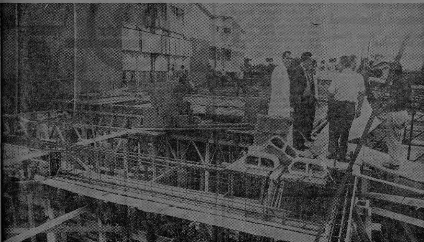
EDIFICIO NUEVO. — Este es el lado este del Hospital Dr. Calderón Guardia donde se construye un edificio de dos pisos para ser ocupado en su planta baja por la cocina, el comedor y la ropería del centro hospitalario; y su planta alta por vestidores y residencias para médicos. Su entrada quedará frente a la Clínica Central.
